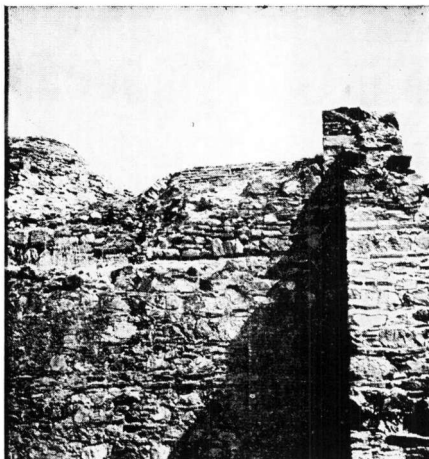
α. Τοιχοποιία της δυτικής πλευράς. Φαίνεται ο τρόπος δόμησης του θόλου του χλιαρού χώρου και τον τρούλου του ζεστού χώρου.
